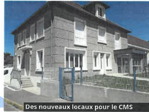
Des nouveaux locaux pour le CMS
