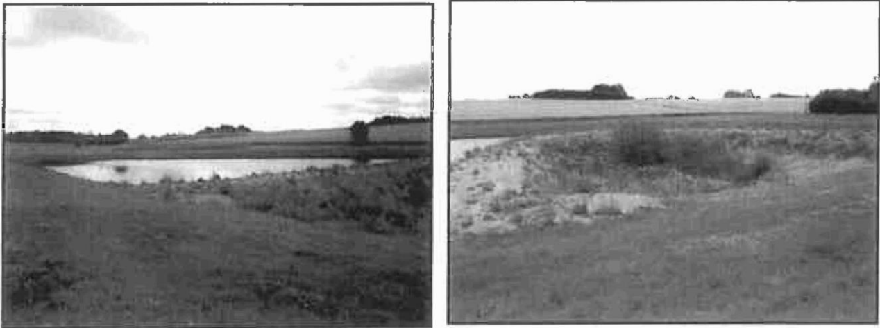
Réhabilitation du bassin pluvial
